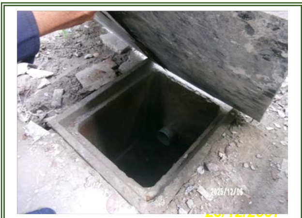
รูปที่ 2-27 ระบบบำบัดน้ำเสีย
